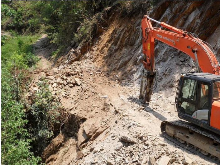
Ein befahrbarer Weg entsteht
