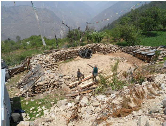
Weiteres Baugrundstück in Vorbereitung
